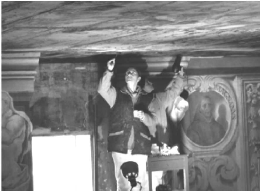
La restauration du plafond
